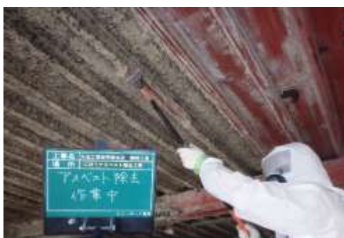
アスベスト除去作業中
