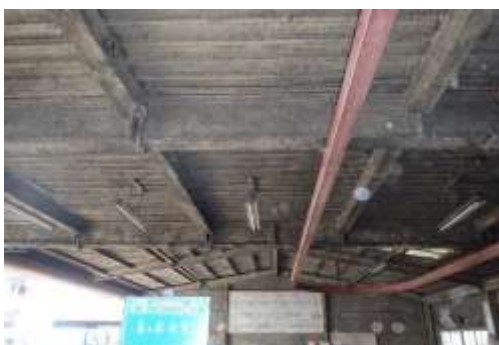
着工前の作業場内
