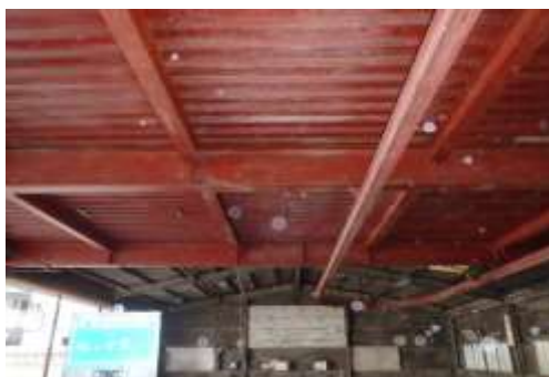
除去作業完了後
