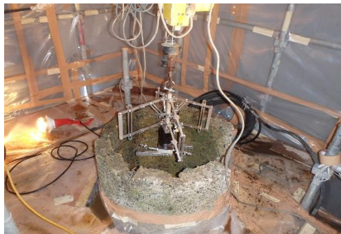
ダイオキシン処理 煙道洗浄機器設置
