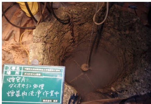
ダイオキシン処理 煙道内洗浄作業中
