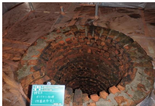
ダイオキシン処理 煙道洗浄完了
