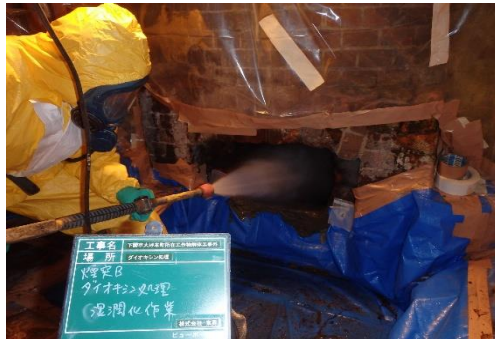
ダイオキシン処理 湿潤化作業
