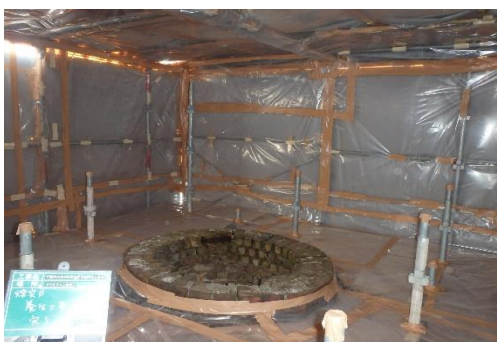
作業場内養生完了
